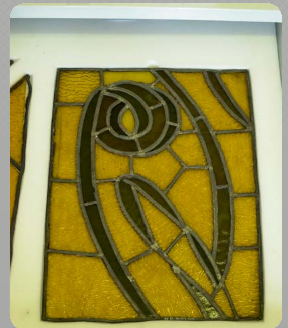
Glasraam bewaard in uitgesneden PE-schuimplaat. Foto: FARO.
