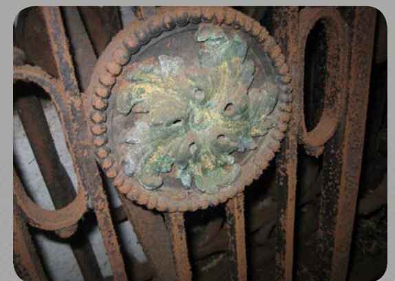
Roestvorming op smeedijzeren hekken veroorzaakt materiaalverlies. Foto: Derek Biront.
