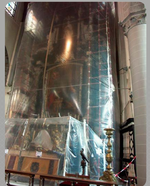
Toepassing van houtwormbestrijding met lage zuurstofconcentratie, ter plaatse op barokaltaar.
