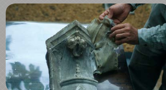
Reinigen van gips met lijnstrappo.
