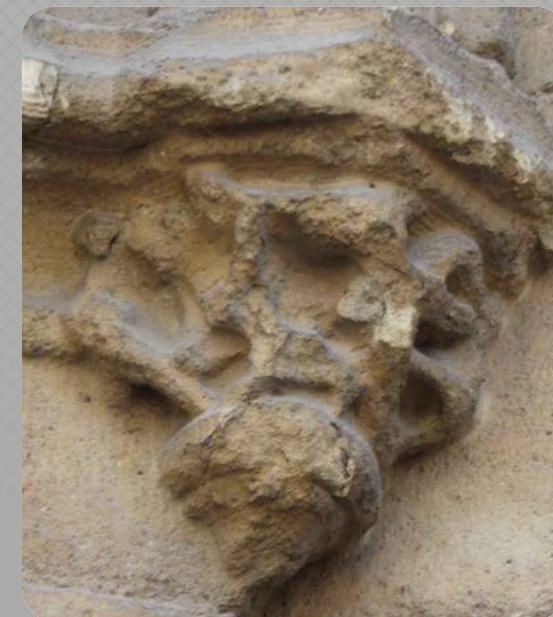
Verwerking van laatgotisch bladmotief door hogedrukreinigen.
